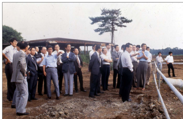
ライナック建設現場の視察風景 (1978年)
