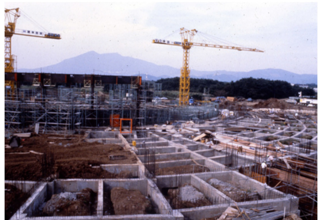
PF 光源棟建設の様子（1980年）
