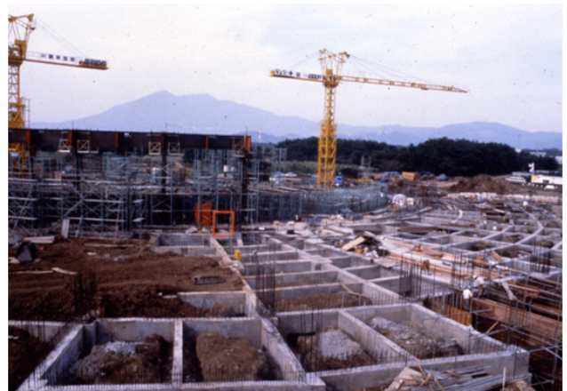
PF 光源棟建設の様子（1980年）
