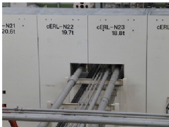
図 2 cERL の建設現場の様子。(上) 放射線シールドブロック設置作業。(下) 既に設置されているヘリウム冷凍設備の配管はそのままにして、シールドブロックを設置する。
