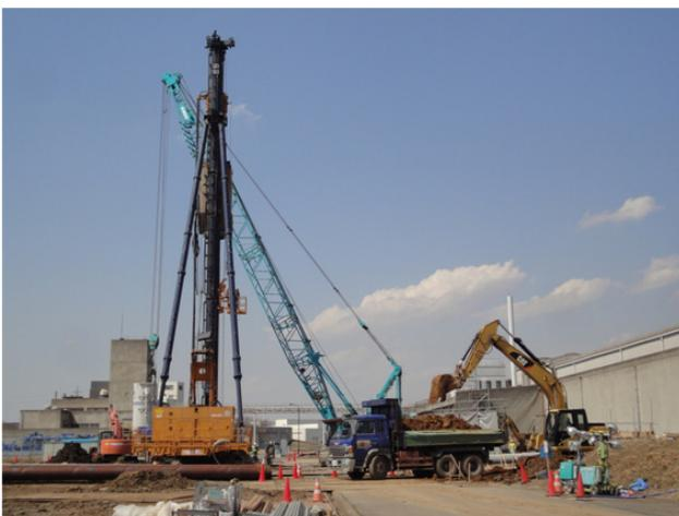
図1 入射器の西側で進むダンピングリング建設のための杭打ち作業。並行してA1電子銃室拡張工事、加速管準備室拡張工事なども進んでいる。
