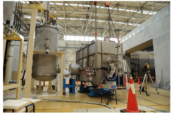
図3 超伝導空洞を搭載したクライオモジュールの現場への設置作業。
