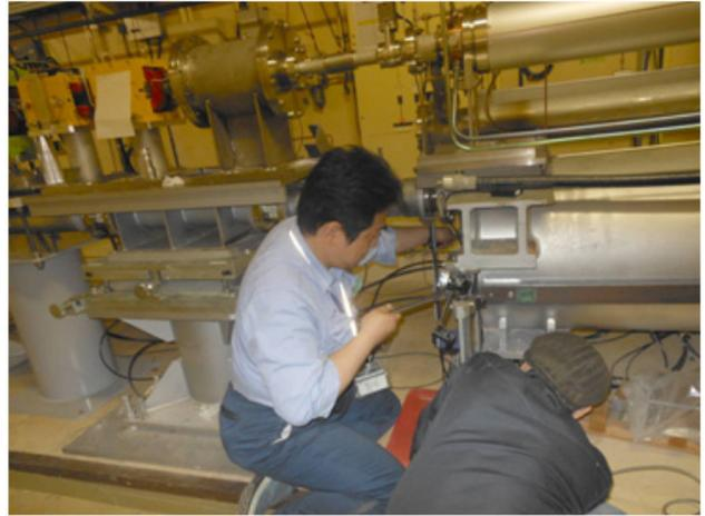
図1 震災を受けた架台を修復しながらアライメントを進めている。
