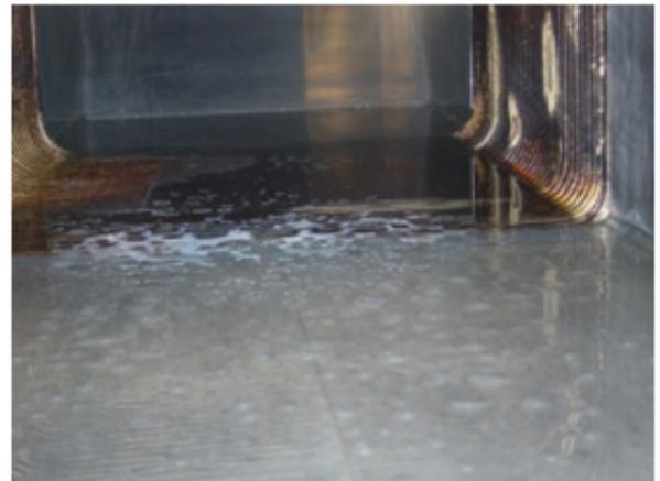
図2 冷却水漏れを起こしたサーキュレータ (上図)。下図はサーキュレータ内部の様子。
