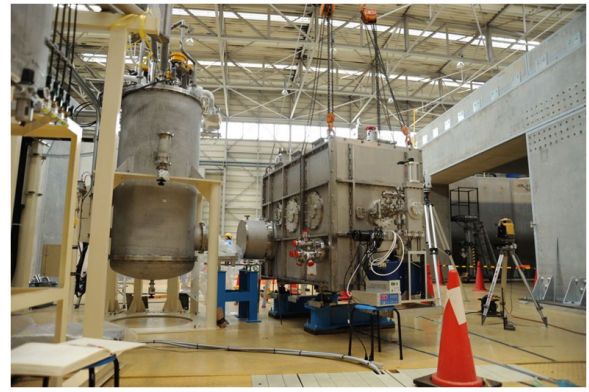
図3 超伝導空洞を搭載したクライオモジュールの現場への設置作業。
