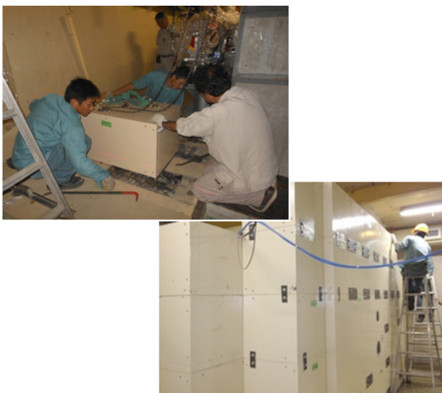
図1 シールド移動作業の一部。複数のグループの同時作業の調整が必要であった。
