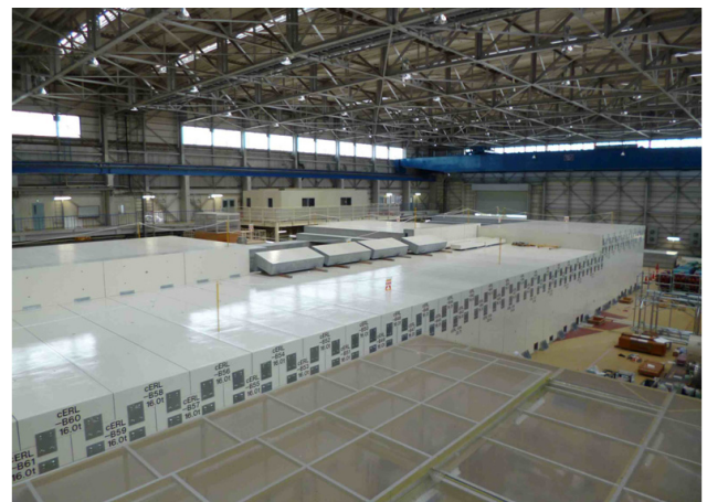
図6 9月末に設置が終了したシールドブロック。
