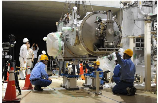
図5 現場に設置された主加速部超伝導空洞クライオモジュール。
