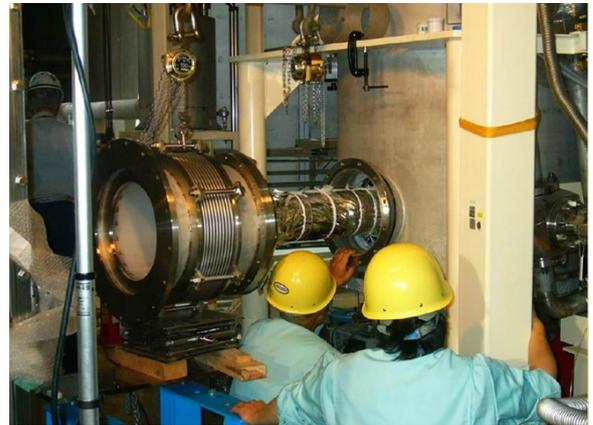
図1 7月に行われた冷凍設備（2 K コールドボックス）との接続作業の様子。
