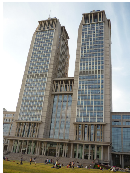
図1 会場となった復旦大学内のツインタワー。
