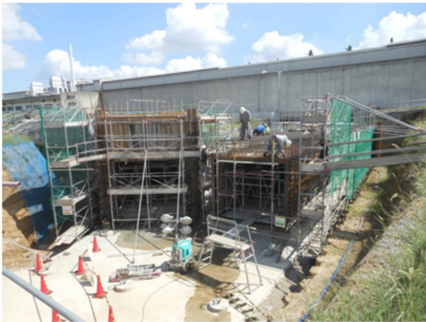
図3 ダンピング・リングの基礎工事が終わり、トンネルの構築が進んでいる。
