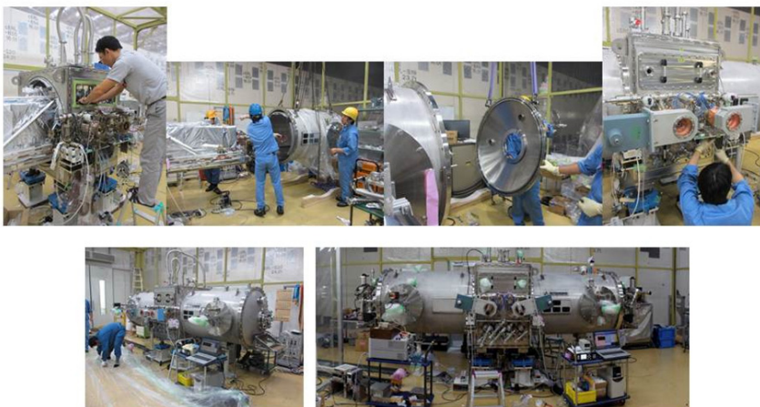
図4 9月には主加速部超伝導空洞の温度センサー、磁気シールド、各種配線の整理を行い、クライオモジュールに組み立て完了。
