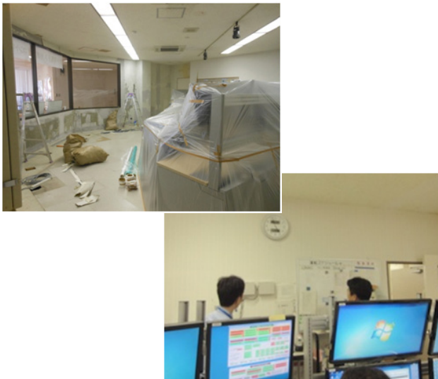
図4 制御室の改装。一部残っていた30年前の設備を撤去・改修した。
