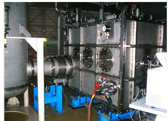
図2 接続作業が完了した前段加速超伝導空洞クライオモジュール。
