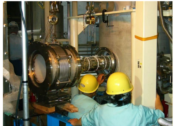
図1 7月に行われた冷凍設備（2 K コールドボックス）との接続作業の様子。
