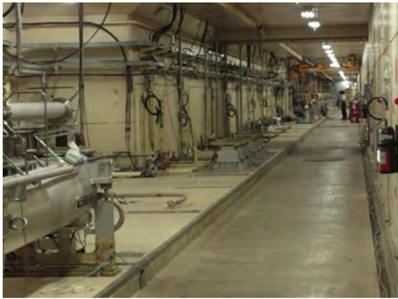
図3 旧陽電子生成部が撤去され、新規改造架台の運びこみを待つ第1セクタ後半部。
