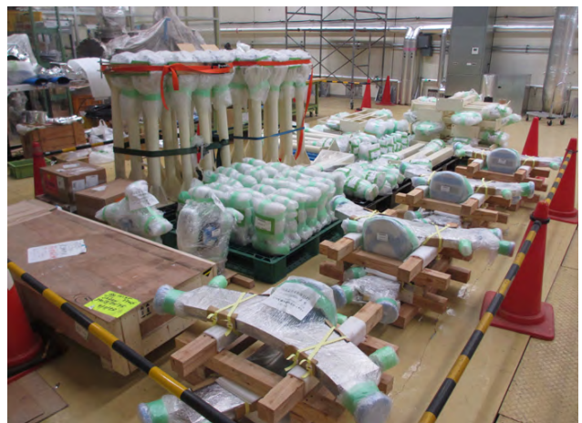
図2 8月からの作業で設置を待つマグネットの架台(上)と真空ダクトの部品(下)。
