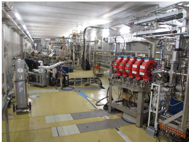
図1 7月からの作業で交差部のダクトが早々に取り外された現場。
