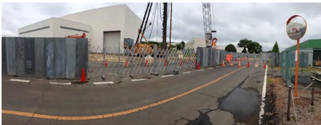
図3 富士実験棟前からAR南実験棟の方角を撮った光景。6月10日から直接入射路下流部から杭打ちが開始された。
