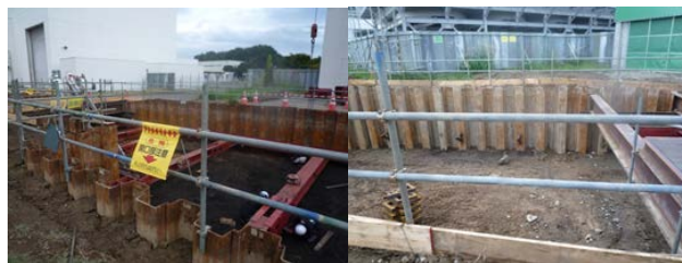
図3 PF-AR 南実験棟前（左図）と D7 電源棟前（右図）の掘削が行われている。
