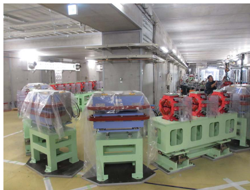
図1 一般公開前の周回部の様子。ベースプレートの設置、マグネット架台の設置、電磁石の設置まで、無事終了した。
