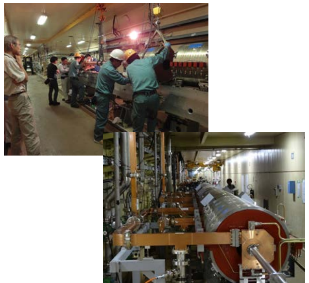
図2 陽電子生成部(ユニット#16)のLAS加速管と集束ソレノイド電磁石の設置作業と、設置後。
