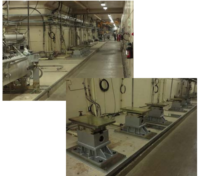
図1 撤去された陽電子生成部と、重量のある新規陽電子生成部(ユニット#16)の架台脚。
