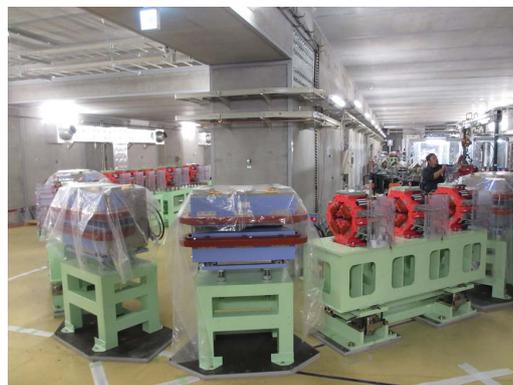
図1 一般公開前の周回部の様子。ベースプレートの設置、マグネット架台の設置、電磁石の設置まで、無事終了した。
