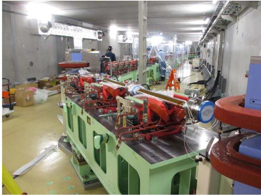
図2 (上) 測量をしながら真空ダクトを設置している様子。(下) 設置が完了した南側の直線部。
