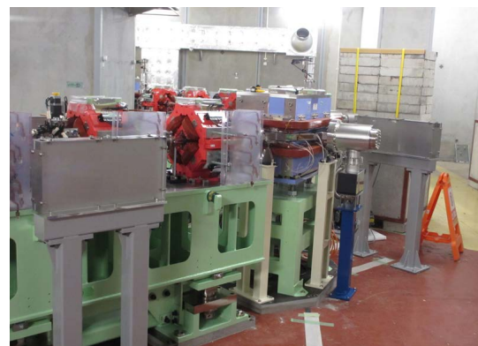
図 3 周回部から発生する可能性があるビームロスに備えた周回マグネット近傍に設置した放射線シールド。
