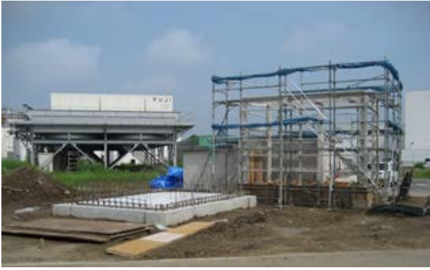
図4 地上部の機械棟（右側骨組み建設中）および制御機器収納庫（左側基礎建設中）。
