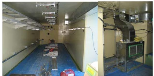
図 3 左写真はトンネル内の一部である。壁の塗装が終了し、左上部に 2 段のケーブルラダー、左下部には排水用水配管、中央上部には照明機器、右上部には空調吹き出し口が通っている。奥に見える壁は共同溝と交わる部分。右写真は、空調吸い込み口の場所。
