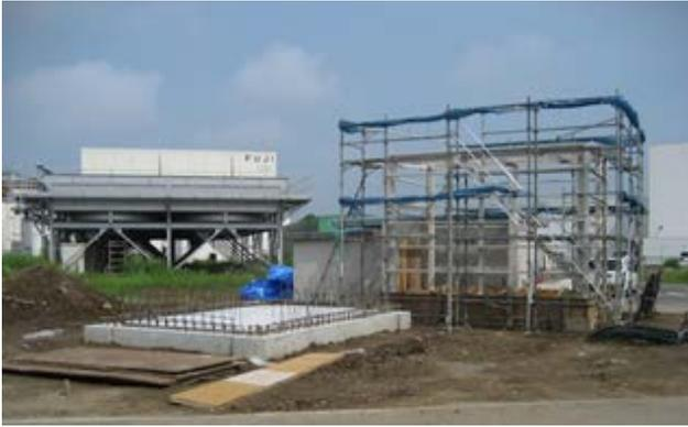
図4 地上部の機械棟（右側骨組み建設中）および制御機器収納庫（左側基礎建設中）。
