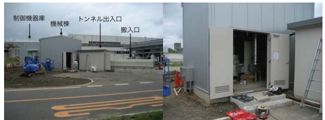
図 4 新トンネル地上部 (左図) および機械棟内部 (右図) の様子。
