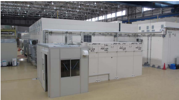
図4 建設されたレーザーコンプトン散乱実験ステーション。
