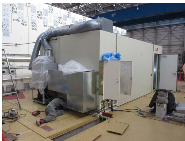
図1 加速器室外に設置される大強度CWレーザーを設置するレーザーハットの建設の様子。
