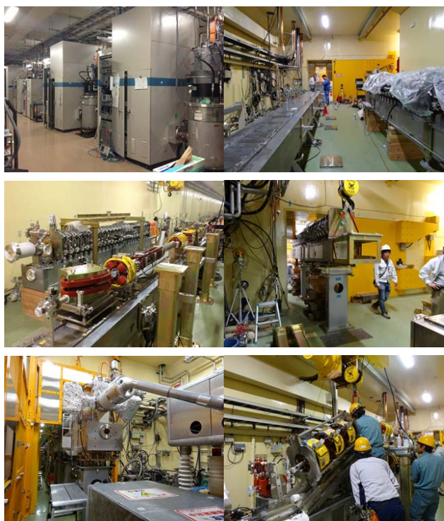
図4 (a) 地上ギャラリーでの2つのサブハーモニックバンチャ用と大電力Sバンド用のマイクロ波源の再配置。(b) 地下トンネルでの加速機器の一時撤去と架台の修復・構築。(c) RF電子銃用ビームラインの再構築と熱電子銃ビームライン用の支柱の構築。(d) 新規架台を設置し、75 cm 引き上げた熱電子銃。遮蔽は未設置。(e) 200 kV 高電圧ステーションのある電子銃室から見た熱電子銃。手前は長基線アライメントレーザ。(f) 構築の進む RF 電子銃と熱電子銃の2つのビームラインの合流部。電磁石は再利用。
