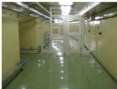
図4 PF-AR 直接入射路新トンネル下流部に設置された KEKB ビーム輸送路との境界領域を区切るフェンス。扉の左横の四角の部分がビーム輸送通過予定箇所。
