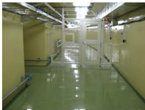
図4 PF-AR 直接入射路新トンネル下流部に設置された KEKB ビーム輸送路との境界領域を区切るフェンス。扉の左横の四角の部分がビーム輸送通過予定箇所。
