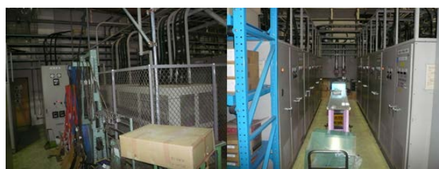
図5 PFリングの偏向電磁石電源の受電盤（左）と大型4極、6極電磁石電源（右）。
