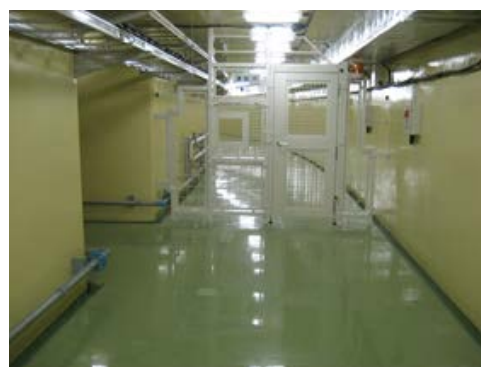
図4 PF-AR 直接入射路新トンネル下流部に設置された KEKB ビーム輸送路との境界領域を区切るフェンス。扉の左横の四角の部分がビーム輸送通過予定箇所。
