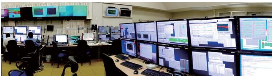
図1 SuperKEKB 制御室内の入射器用コンソール群(右)と全体運転コンソール(左正面)。さらには左にはリングの電磁石、マイクロ波、真空、ビームモニタ、Belle-2/Beast など各グループの端末が並んでいる。また、右奥にはPF-AR向けコンソールや全体安全コンソールがある。
