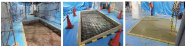
図2 床補強工事の様子
