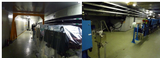
図4 写真はPF-AR現ビーム入射路に設置してある偏向電磁石の一部(左)、南東直線部(SE12-13間)の真空ダクトをはずし、運搬路を確保した様子(右)。
