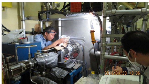
図2 超伝導垂直ウィグラーの断熱真空リーク対処作業の写真。
