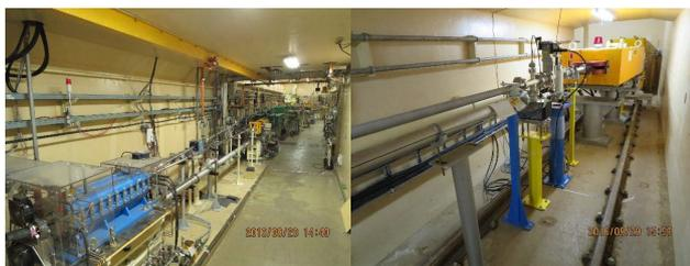
図4 PF-AR 直接入射路の LINAC-SY3 の分岐点。手前のパルス偏向電磁石で PF-BT, PFAR-BT, KEK-BT が分岐する(左図): SY3 のダンプラインを通過する PFAR-BT (右図)。
