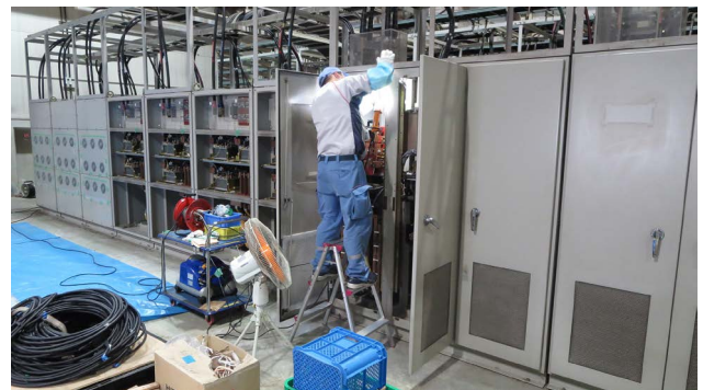
図4 PF電源棟に設置してある大型電磁石電源の保守作業の様子。
