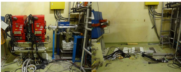
図3 超伝導ウィグラー真空チャンパー更新作業の現場の状況：左図は作業前の状況、右図はウィグラー下流にあるダブレット4極電磁石が撤去された直後の状況を示す。
