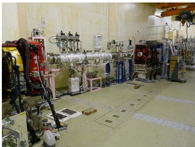
図1 R#19撤去前後のB18-B19間直線部の様子を示す。R#19設置のために補強していたH鋼も撤去され、B18-B19間のトンネル内側がフラットな状態になった。
