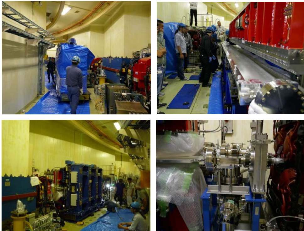
図4 U#19のPFリング加速器室内搬入作業の様子を示す。(上左図)リング内側を時計回りに移動、(上右図)B18-19間直線部前で真空チャンバーの設置、(下左図)ビーム軌道に合わせるように押し込む、(下右図)U#19の真空チャンバーをリング側のチャンバーに接続。
