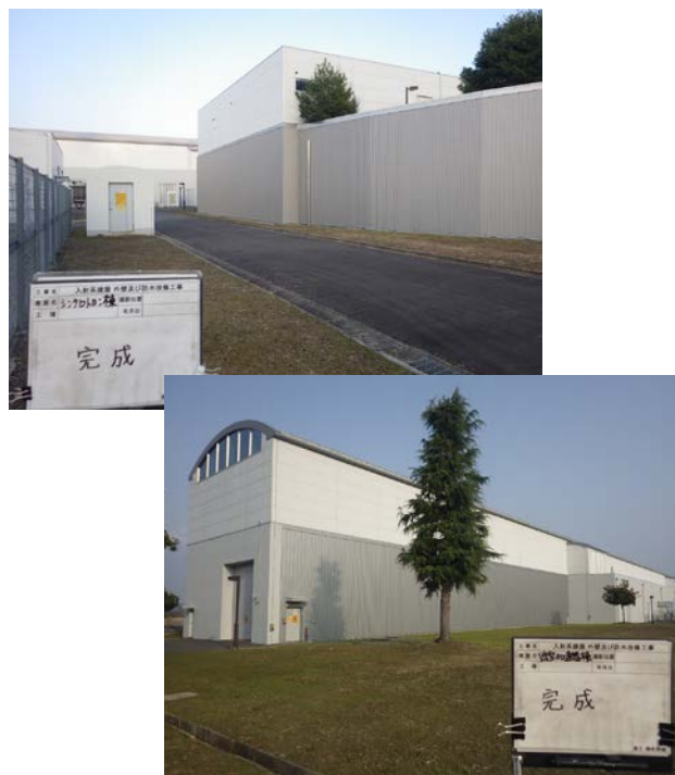
図 1 理化学研究所での入射系建屋外壁及び防水改修工事（設計・監理：株式会社 内藤設計）
