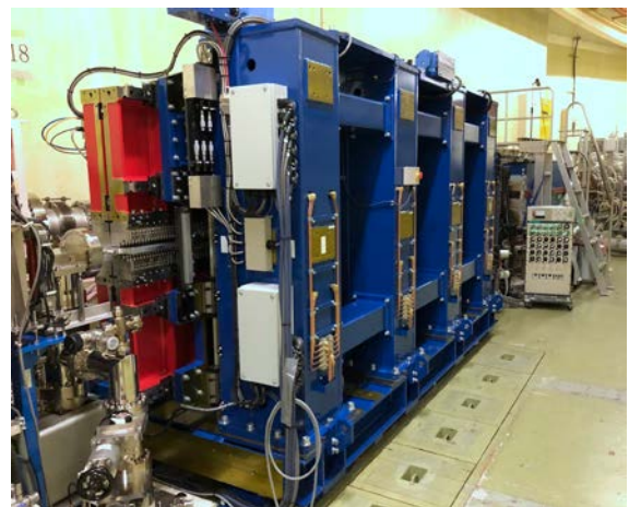
図5 現場設置後のアンジュレータU#19。真空ダクトは磁石列の最小ギャップ23 mmに対して1.5 mmの隙間で設置されている。
