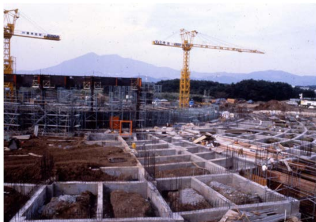
PF 光源棟建設の様子（1980年）
