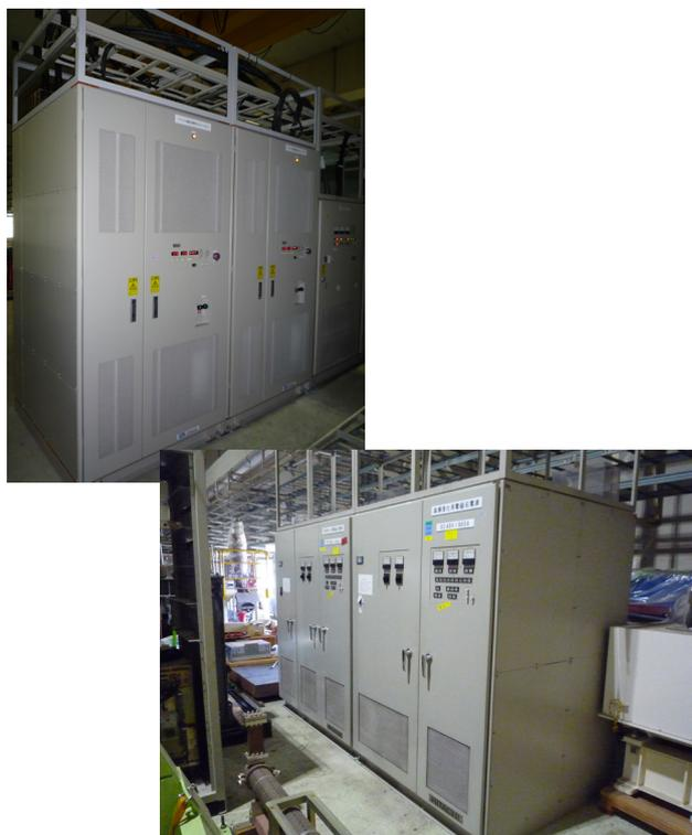
図 3 PF リングの新規に製造された 4 極電磁石電源 2 台 (左上) と交換され保管されている旧 4 極電磁石電源 (右下)
