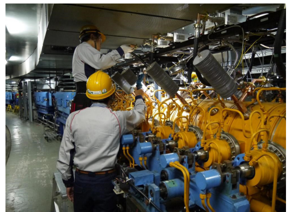
図 5 高次モード (HOM) 引き出し用ケーブルの更新作業の様子
