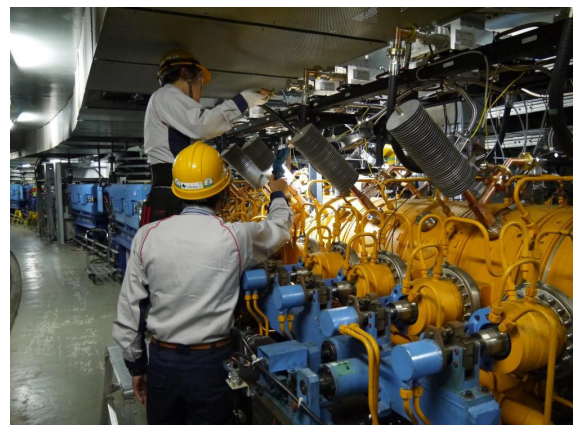
図 5 高次モード (HOM) 引き出し用ケーブルの更新作業の様子
