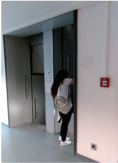
図1 エスカレーター風エレベーター
