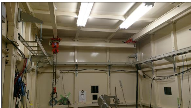
分電盤、電気配線、ラダー、チェーンブロック
