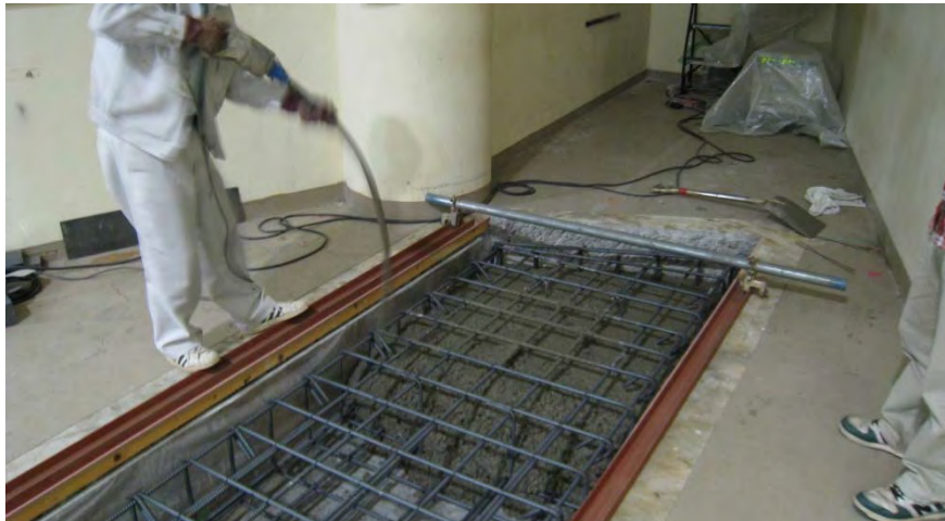
コンクリート打ち(黄金週間中)
