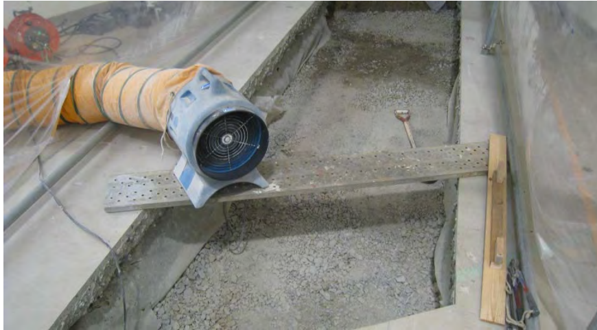
床はつり(春のシャットダウン中)
