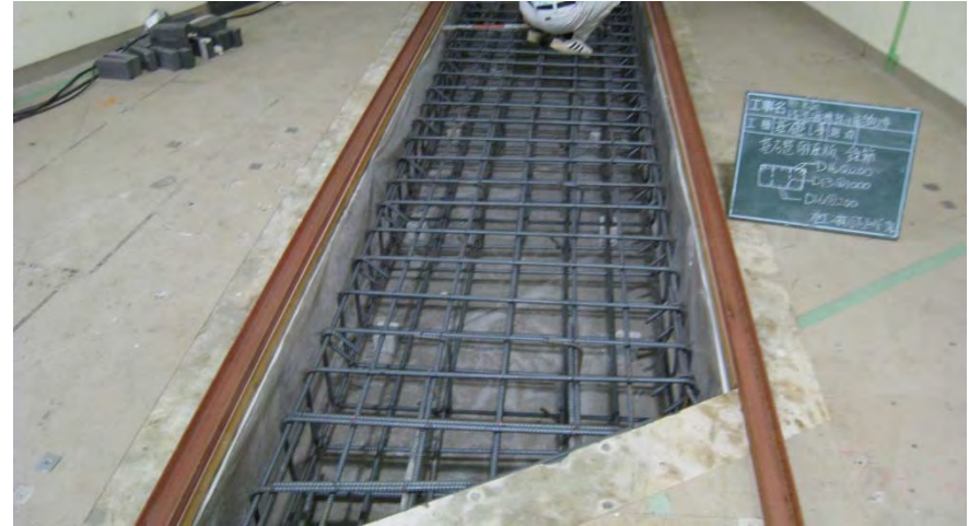
鉄筋組み(4月運転終了後)
