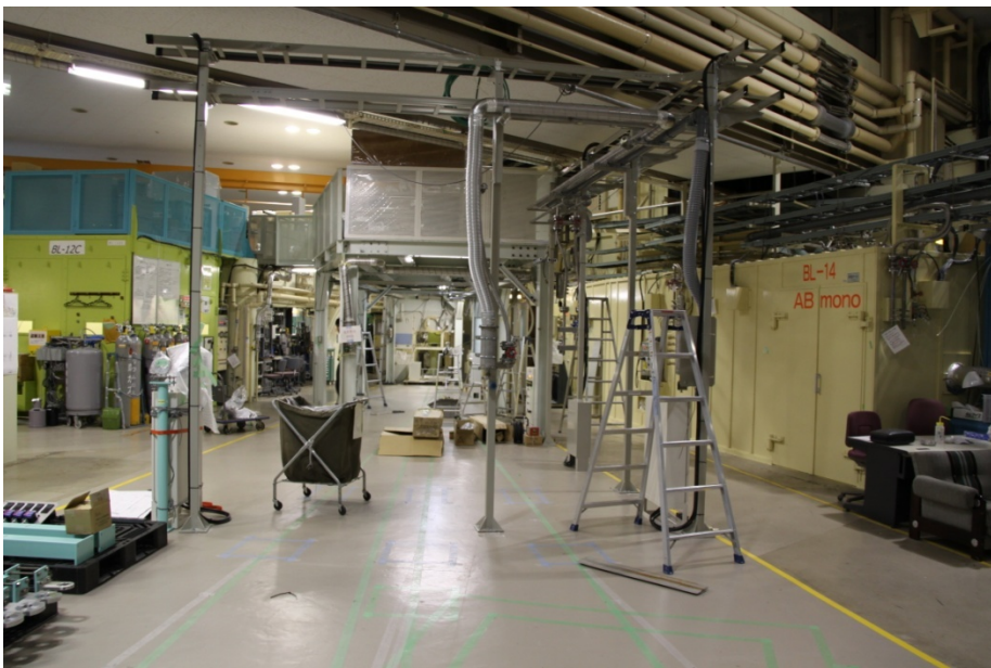
床補修、ラック工事
